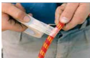
1. Injekcijsko cev oblepimo z lepilnim trakom z vlakni.
