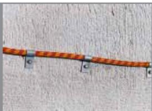
5. Cev odvijemo iz koluta in jo namestimo na spoj. Drugi metuljček pritrdimo kot je opisano v korakih od 1 do 4.
