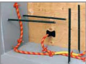
6. Pri križanju dveh cevi eno izmed njih oblepimo, da preprečimo zamašitev injekcijske cevi med injektiranjem druge.
