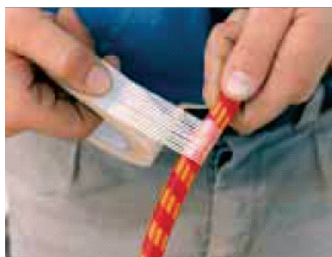
1. Injekcijsko cev oblepimo z lepilnim trakom z vlakni.
